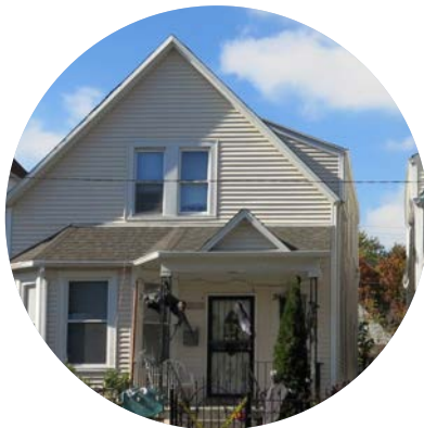
Chicago, IL - Chicago Retrofit
